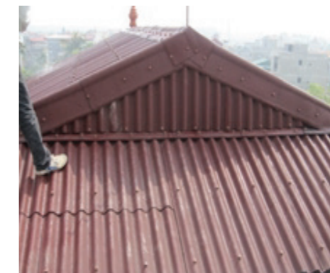
Dùng tấm úp nóc để xử lý vị trí ngã 3 giao nhau
