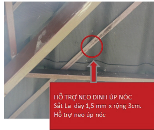
Bổ sung thêm 2 lá thép hoặc la gỗ để có chỗ bắt vít tấm úp nóc
