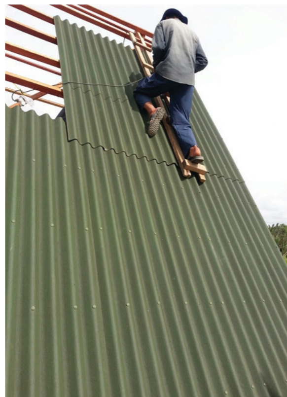
Sử dụng thang gỗ hoặc thang tre để lót trên tấm tole sinh thái onduline khi thi công
