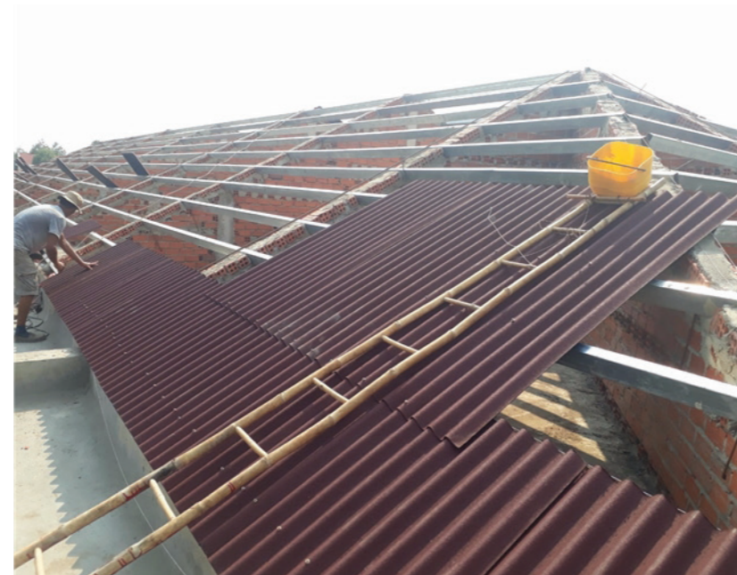
Sử dụng thang gỗ hoặc thang tre để lót trên tấm tole sinh thái onduline khi thi công
