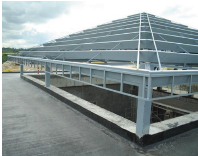
Bổ sung thêm 2 lá thép hoặc la gỗ để có chỗ bắt vít tấm úp nóc
