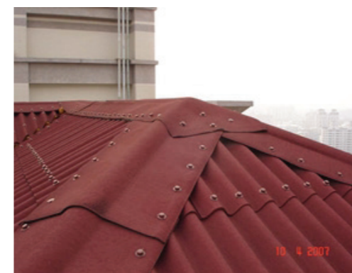
Dùng tấm úp nóc để xử lý vị trí ngã 3 giao nhau
