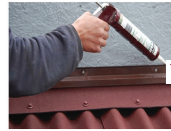
Vị trí tiếp giáp phần cao nhất của mái với tường đối với nhà 1 mái
