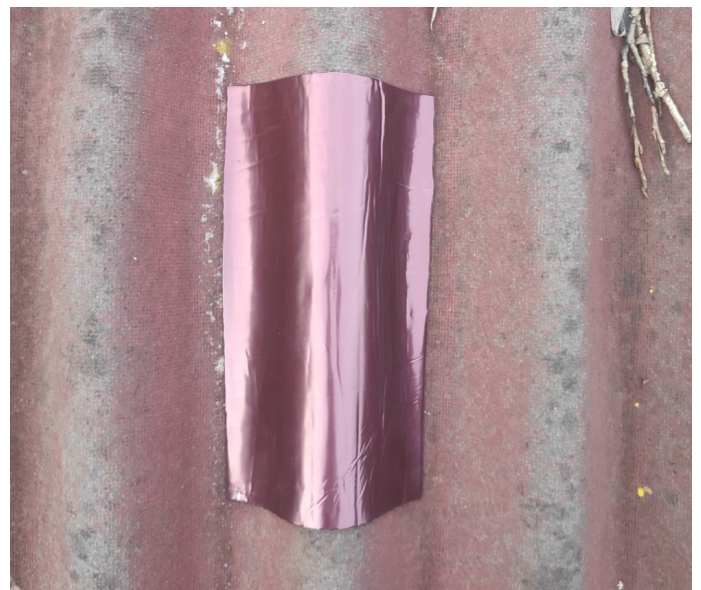
Hình 9 - Băng keo ONDUBAND sau khi dán
