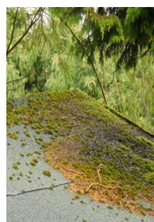
Hình 4- Rêu mọc trên lớp lá mục trên mái lợp phủ ni trong bóng râm. Rêu phát triển mạnh trong điều kiện ẩm ướt và râm mát.
