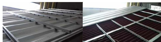
Mái nhà mẫu được lắp đặt
